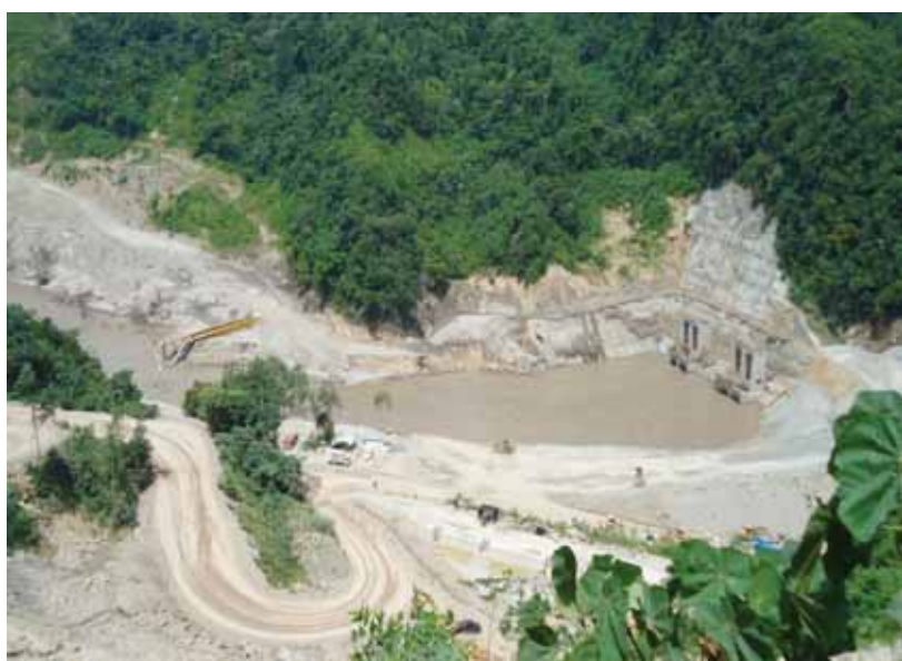
Foto 2. Construcción de Hidrosogamoso, túneles de desvío. Junio, 2011. Tomada Por: Roa, T
