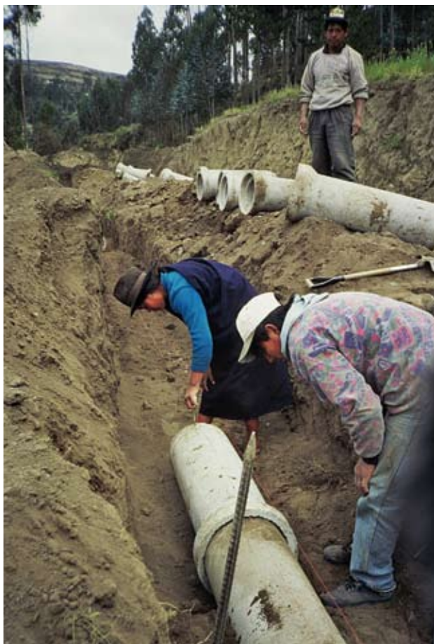
Gladys Yupa, liderando a su equipo de albañilería en la construcción de un canal de tubería.
